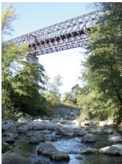
Ponte sul fiume Calore Bridge over the River Calore
